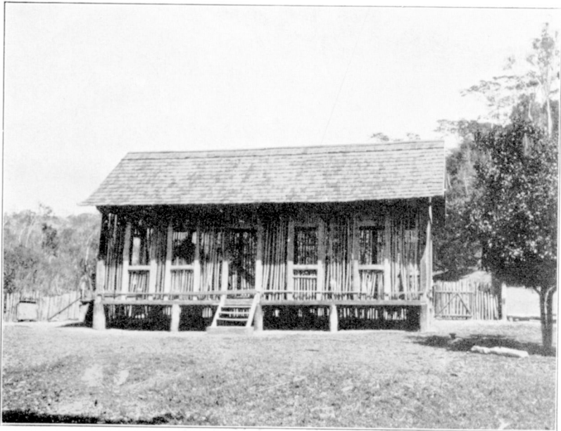
Haus im Bau.
