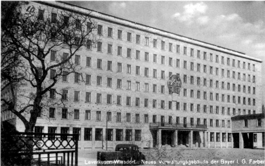
Abb. 5: Das neue Verwaltungsgebäude; im Luftschutzkeller fanden auch polnische Zwangsarbeiterinnen aus dem daneben gelegenen Barackenlager Schutz bei Fliegeralarm. Regina schrieb diese Karte am 19.11.1942 an ihre Mutter; sie war seit neun Monaten in Leverkusen. (Dokument 18.10).
