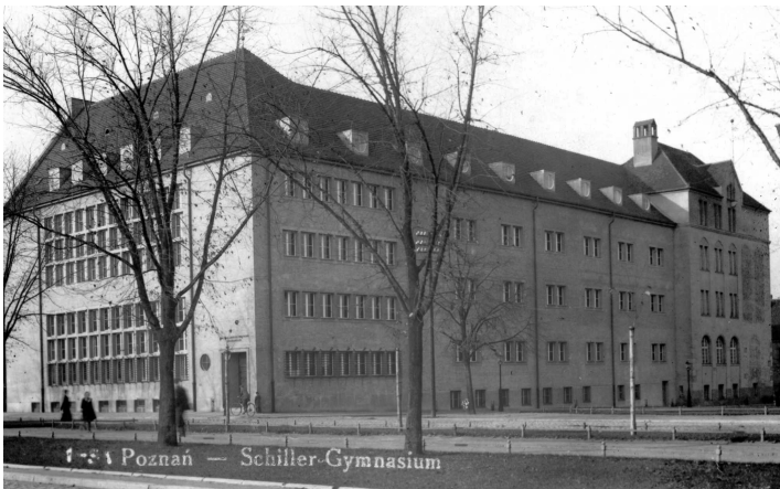
Abb. 2: Das Schiller-Gymnasium in Posen, ca. 1936.
